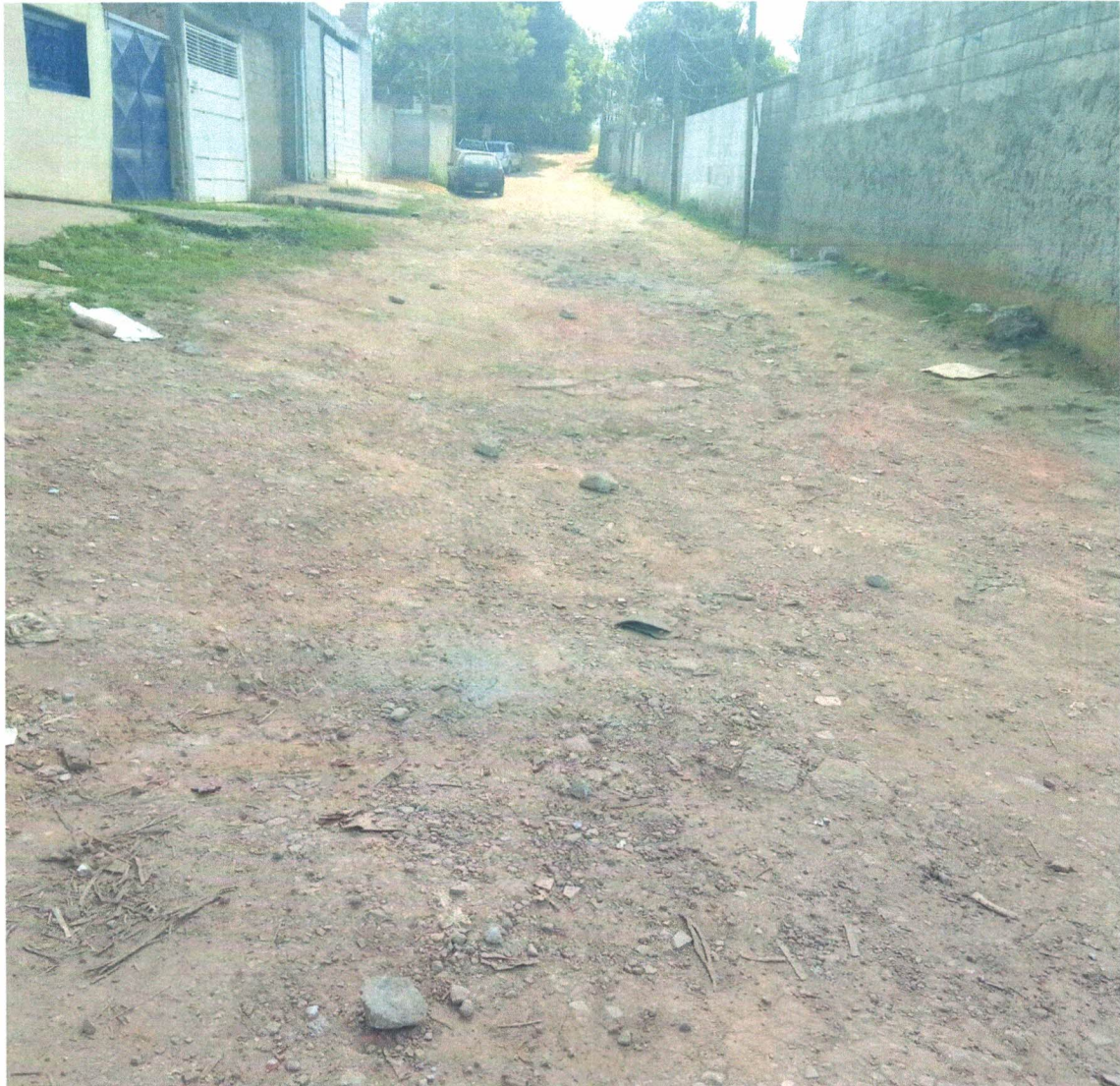
IMPLANTAÇÃO DE REDE DE ESGOTO EM TODA A EXTENSÃO DA RUA CEARÁ, CONJUNTO SANTO ANGELO – MOGI DAS CRUZES.
